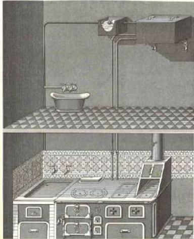
1894年通过带有锅炉的炉灶供应热水的浴室
